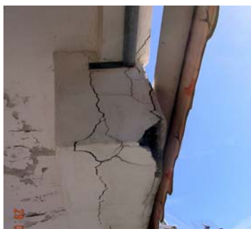
Ρηγματώση παράλληλα στους οπλισμούς
